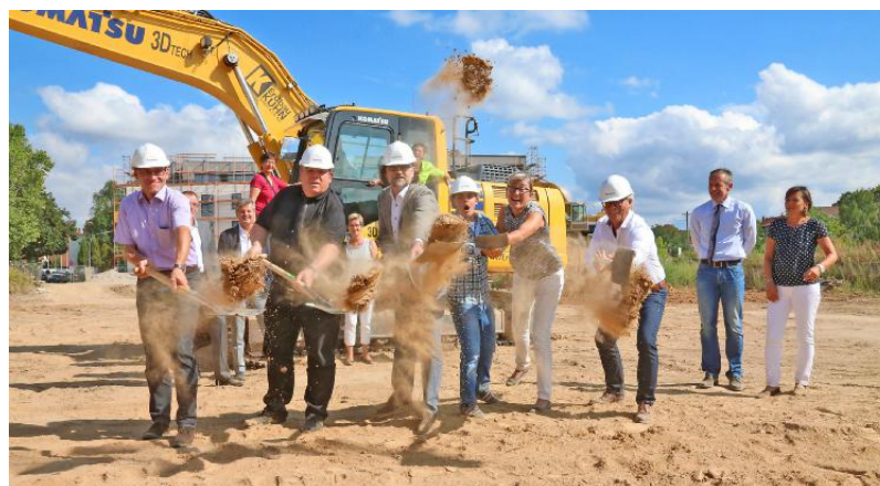
Spatenstich für das Projekt „Buntes Wohnen“ mit Ideengebern, Investoren, Architektin, Baudezernenten und künftigen Bewohnern. Foto: Guido Sawatzki
